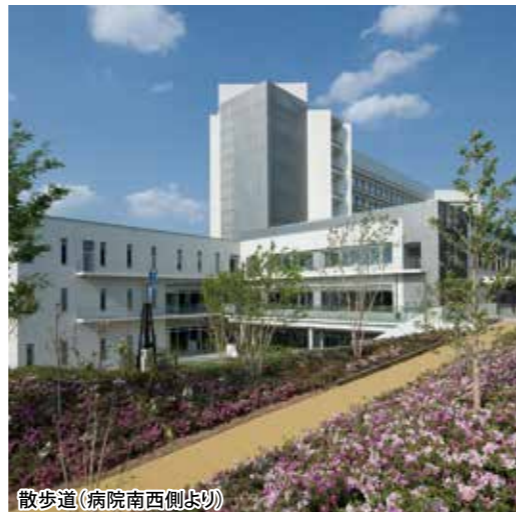
散歩道(病院南西側歩道)
