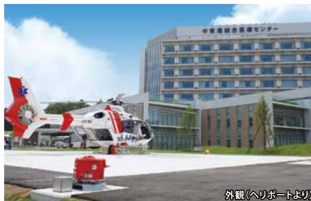
外観(ヘリポートより)
